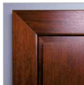
łączenie opasek pod kątem 45°
