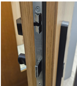
rygiel zamka listwowego MACO MACO slat lock bolt
