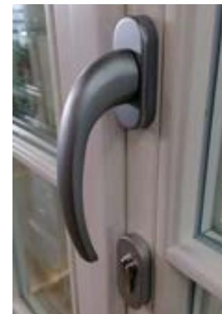
Ein Griff mit Rosette zum Getriebe mit dem Einsatz
